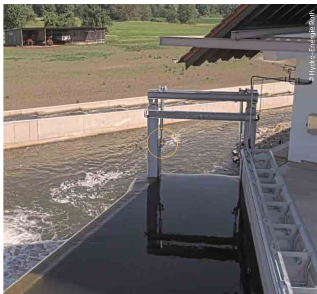
Über den neuen Fischabstieg geht's für die Fische mühelos ins Unterwasser.
