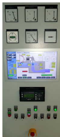
Steuerschrank 1050 kW
